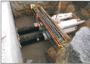
Verfüllung von Fernwärmeleitungen
