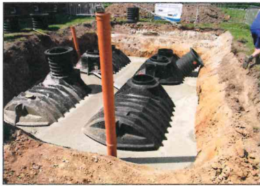
Verfüllung von Kleinkläranlagen
