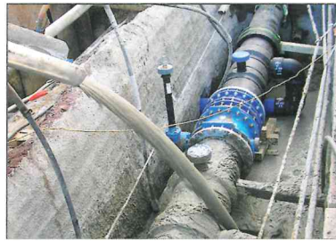
Verfüllungen von Baugruben
