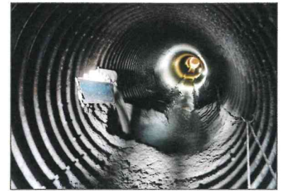
Verfüllung von Schächten
