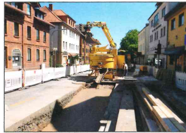
Verfüllung von Rohrleitungen
